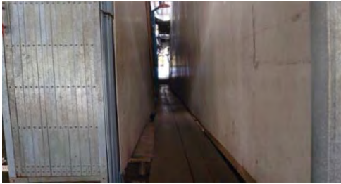
ภาพที่ 13 ทางเดินตรอกโรงผื่นก่อนปรับปรุง
