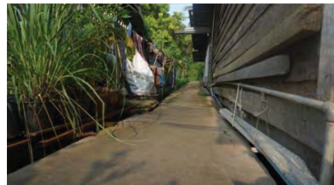
ภาพที่ 11 ทางเดินท้ายตลาดก่อนปรับปรุง
