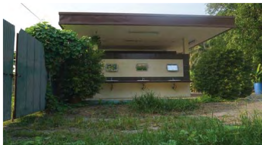
ภาพที่ 9 ห้องน้ำสาธารณะก่อนปรับปรุง
