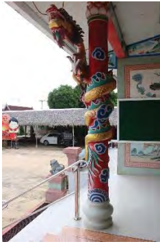
รูปที่ 14 ลักษณะของเสาภายนอก
